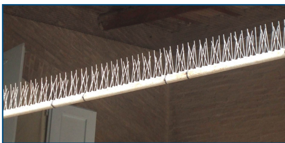
Figura 37. Esempio di punte atraumatiche ben collocate. (eb)
