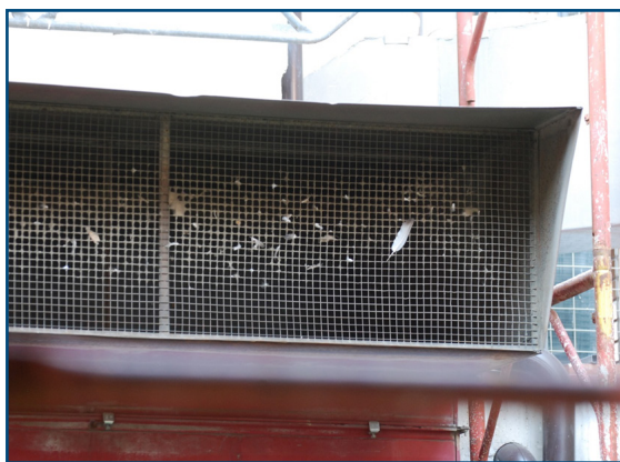
Figura 30. Fteroparosis su presa d'aria di un impianto di condizionamento ospedale. (ag)
