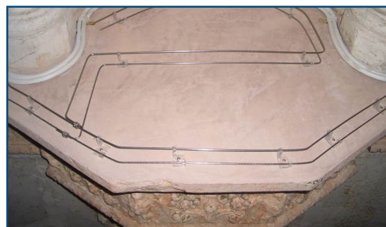
Figura 31. Esempio di dissuasore elettrificato a protezione di un monumento. (eb)
