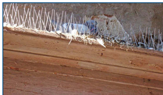
Figura 34. Spesso le punte mal collocate ottengono l'effetto opposto a quello richiesto. (ag)
