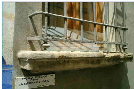
Figura 40. Piano inclinato che impedisce l'appoggio a colombi e gabbiani. (ag)
