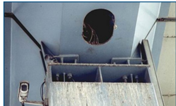
Figura 23. Foro passauomo per manutenzione di montanti stradali senza dissuasori o occlusioni (P.P. Albonetti)
