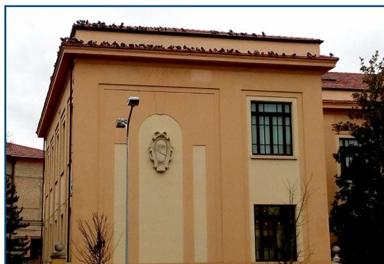
Figura 29. Colombi in elementi architettonici non protetti di edificio urbano (F. De Massis)
