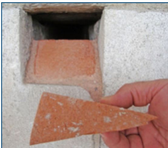
Figura 21. Occlusione parziale buca pontaita (A. Gelati et al. 2014)
