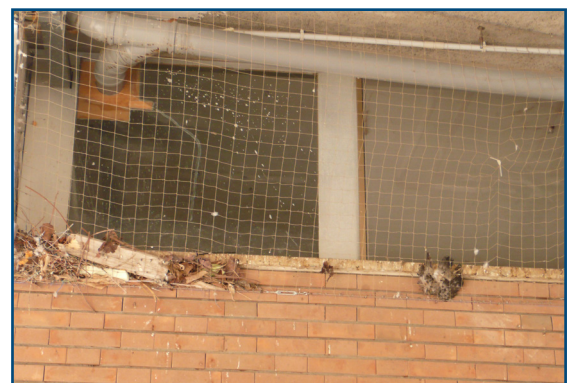
Figura 74. Rete tesa con scarsa manutenzione (P.P. Albonetti)
