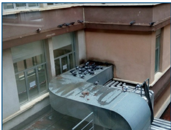
Figura 26. Colombi in elementi tecnologici non protetti di edificio urbano (F. De Massis)
